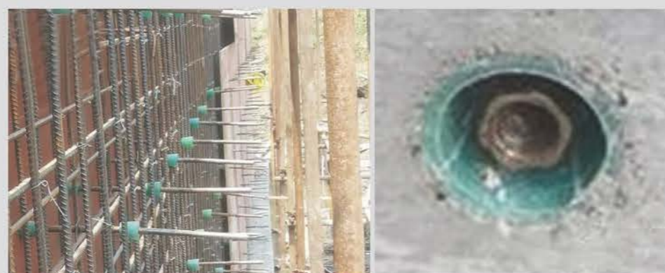
三段式快拆止水螺杆在墙体中应用
