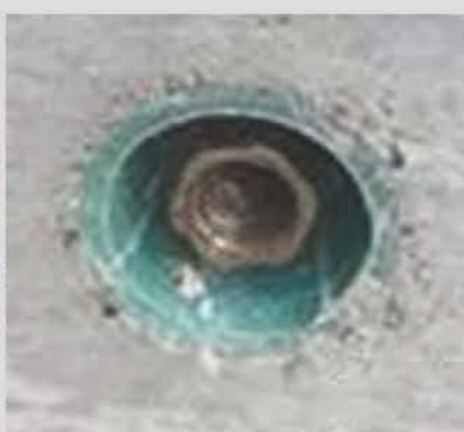
三段式快拆止水螺杆在墙体中应用
