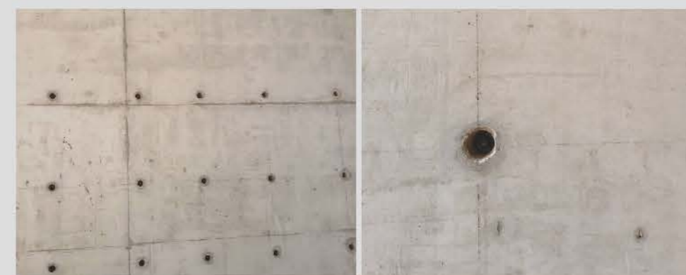
三段式快拆止水螺杆在墙体中应用效果
